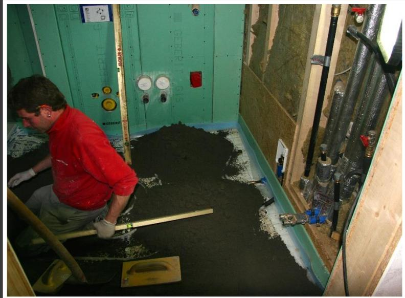
Einbringen des Estrichs nach Verlegung der Fußbodenheizung
