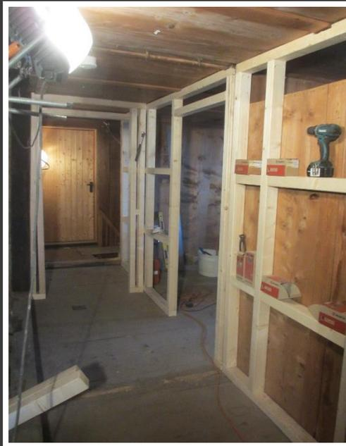
Aufbau der Holzkonstruktion für die zurückgesetzte Wand der Schlafzimmer 1 und 2 (Blick Richtung Süden)
