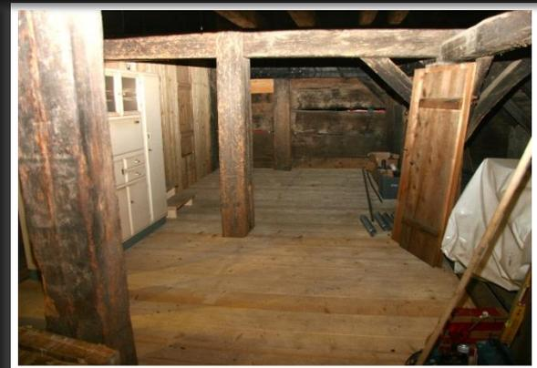
Pelletlager neben der Einfahrt mit neuer Balkenkonstruktion
