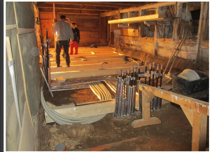
Verlegung der Rohre und Vorbereitung der Bodenkonstruktion
